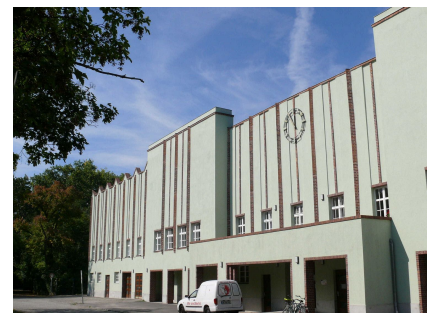
Westlicher und mittlerer Teil des Tribünengebäudes mit dem Haupteingang
