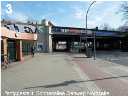
3 fertiggestellt: Sonnenallee Gehweg Nordseite
