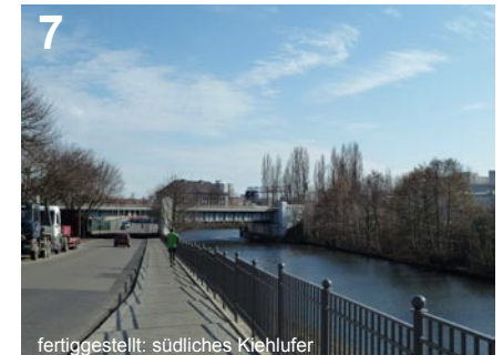
7 fertiggestellt: südliches Kiehlufer
