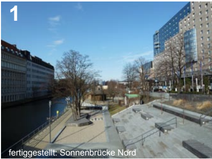
1 fertiggestellt: Sonnenbrücke Nord
