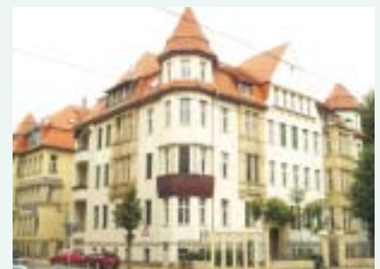
Abbildung 21: Im Rahmen der Selbstnutzerinitiative saniertes Gebäude in der Waldstraße
