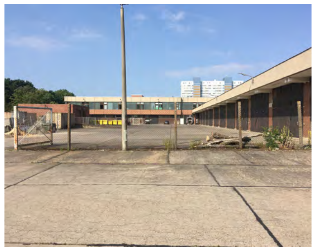
Blick nach Westen, rechts Haus16 (Foto: BSF)
