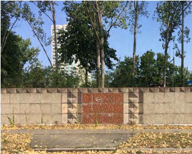
Umfassungsmauer heute im Planungsgebiet (Foto: BSF)
