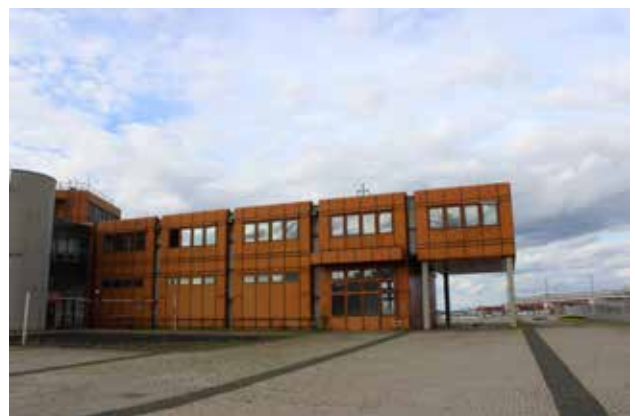
Foto 6: Blick von Westen auf Feuerwache, links Treppenhausturm, rechts östliche, aufgeständerte Durchfahrt, im Hintergrund Terminalgebäude
