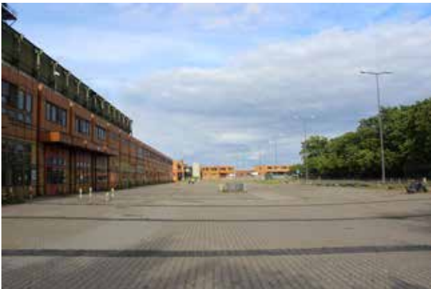
Foto 7: Blick nach Osten über südlichen Vorplatz, rechts Hangarstraße West, links Annexbauten, im Hintergrund Feuerwache mit rundem Treppenhausturm
