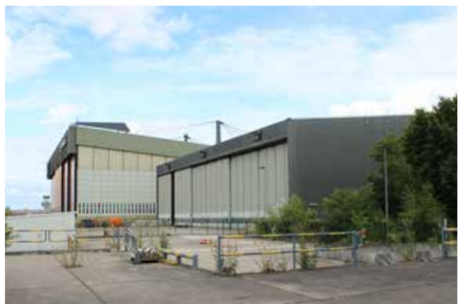
Abb. 41 Blick von Nordwest, vorne Hangar N2, hinten Hangar N1
