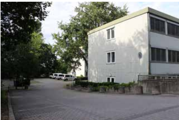
Foto 27: Blick von Hangarstraße West auf Zufahrt zu tieferliegender Stellplatzebene, rechts Bürogebäude Z3
