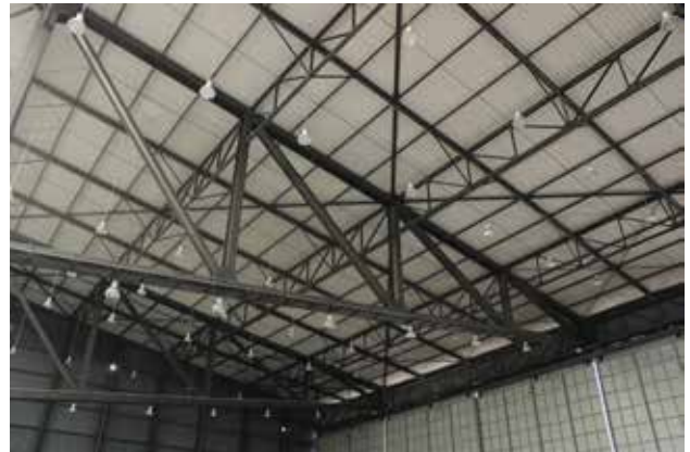
Foto 20: Innenansicht Hangar N2, Blick auf Dachtragwerk
