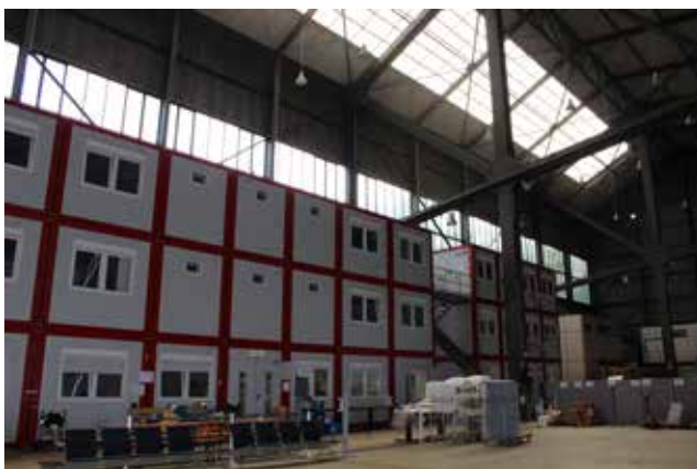
Abb. 40 Hangar N2 mit rückwärtigen Containereinbauten
