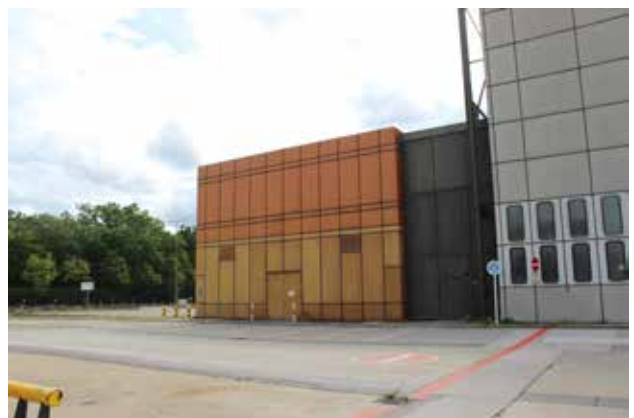
Foto 12: Blick auf Ostfassaden, links Annex N1a, Zwischenbau mit schwarzer Modulfassade, rechts Hangar N1
