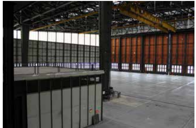
Foto 14: Innenansicht Hangar N1, Blick von Galerie des Zwischenbaus auf mittleren Einbaukubus mit begehbarem Dach
