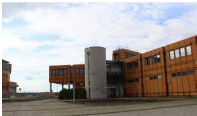
Abb. 33 Feuerwache mit Blick auf südlichen, runden Treppenturm, links aufgeständerte Durchfahrt
