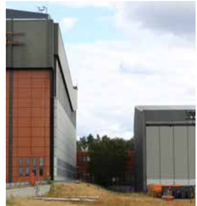
Abb. 9 Höhenversprung zwischen den Hangars
