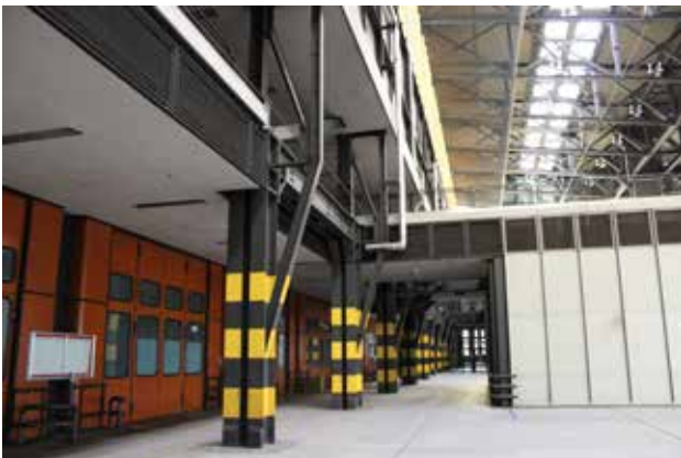
Foto 15: Innenansicht Hangar N1, Blick auf Galerie als Zwischenbau im Erdgeschoss, links Annexbau N1a, rechts mittlerer Einbaukubus
