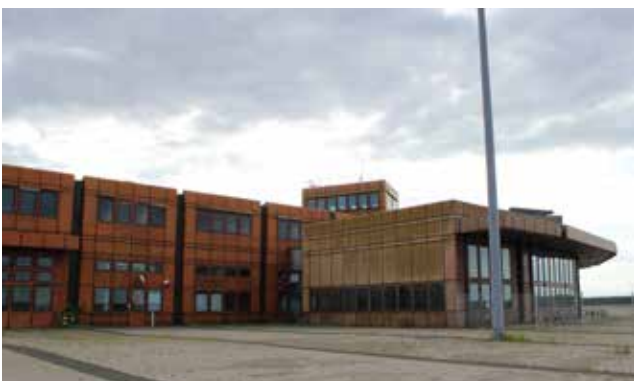
Abb. 32 Feuerwache, rechts Hallen- und Garagenbereich, Blick von Osten
