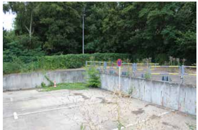
Foto 22: Blick nach Südwesten auf Ladefläche nordwestlich des Hangars N2
