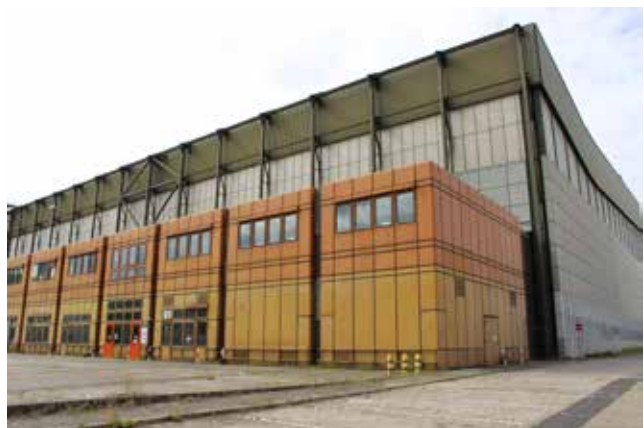
Abb. 37 Süd- und Ostseite Hangar N1 mit Fensterbändern, Vordergrund Annex N1a über dunklen Zwischenbau (rechts im Bild) an Hangar angebunden
