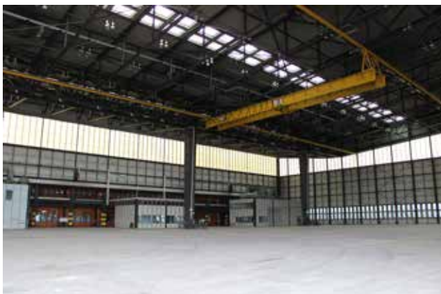
Abb. 38 Hangar N1, mit Blick auf rückwärtige, eingestellte Bauten
