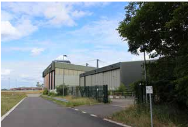
Foto 21: Blick nach Osten, Hangars N2 und Hangar N1
