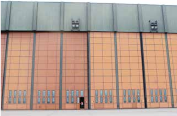
Foto 13: Blick von Norden auf Schiebtorfront des Hangars N1 mit geöffneter Tür
