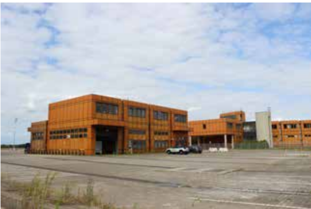
Foto 3: Blick von Südwesten, im Vordergrund Tankdienststation, im Hintergrund Feuerwache mit rundem Treppenhausturm
