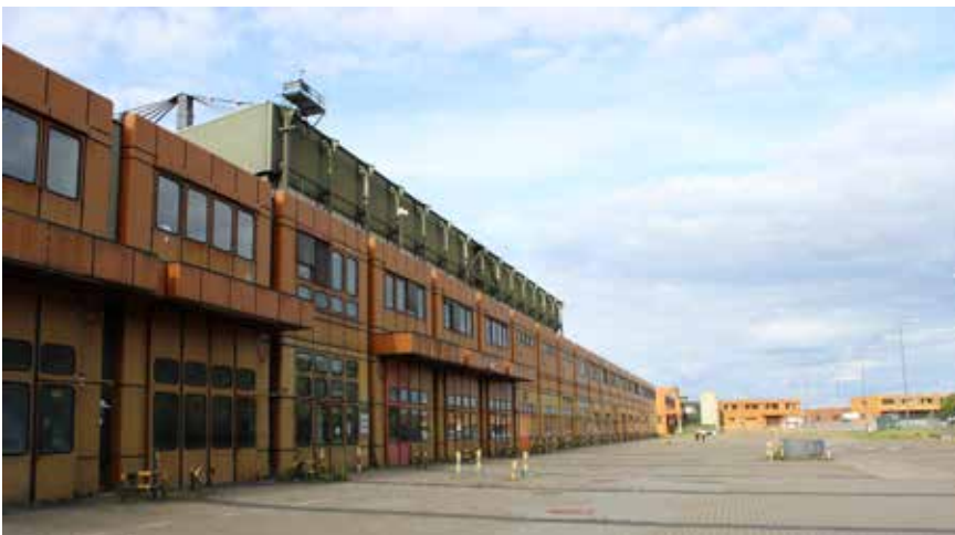
Abb. 44 Flughafenrandbebauung mit südlichem Vorplatz und Rastermarkierung, links Annexbauten, Hintergrund ehemalige Flughafenfeuerwehr mit rundem Treppenturm
