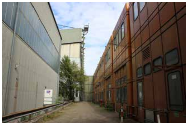
Abb. 43 links Hangar N2 mit Böschungsraben, rechts Annex N2a
