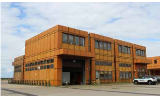
Abb. 34 Tankdienststation M, Blick von Südwest
