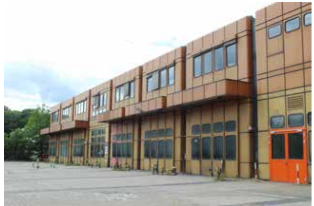
Foto 8: Blick auf Südfassade des Annex N2a mit mittigem Segment für Treppenhau
