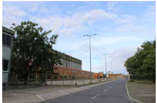
Foto 26: Blick entlang Hangarstraße West nach Osten, links Bürogebäude Z3 und Annexbauten
