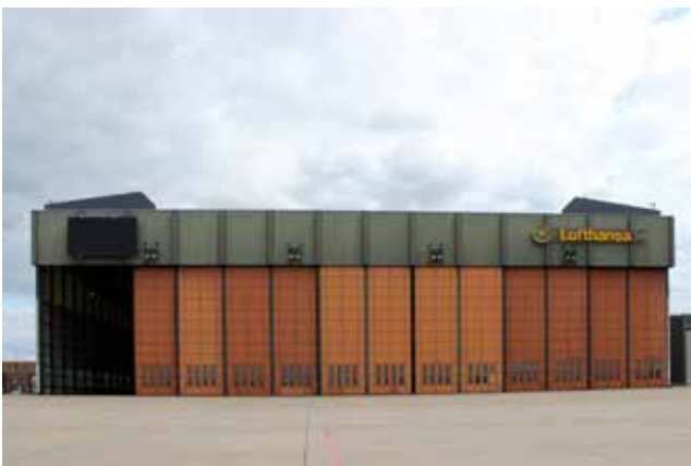
Abb. 36 Nordseite Hangar N1, rechts Teilöffnung der Schiebetore
