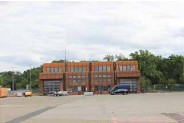
Foto 1: Blick auf Nordfassade der Tankdienststation M
