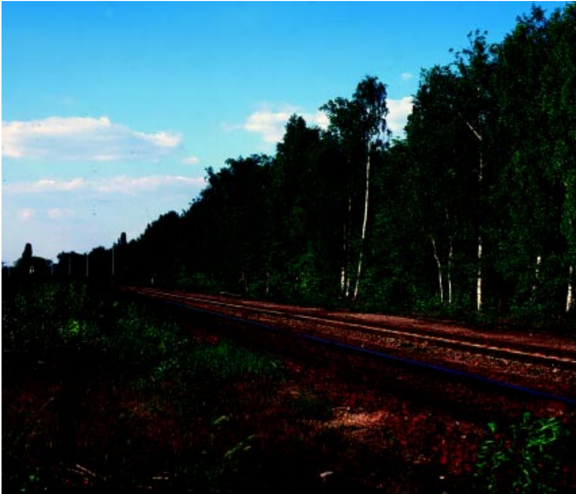
Abb. 6 Neubau von Bahntrassen
