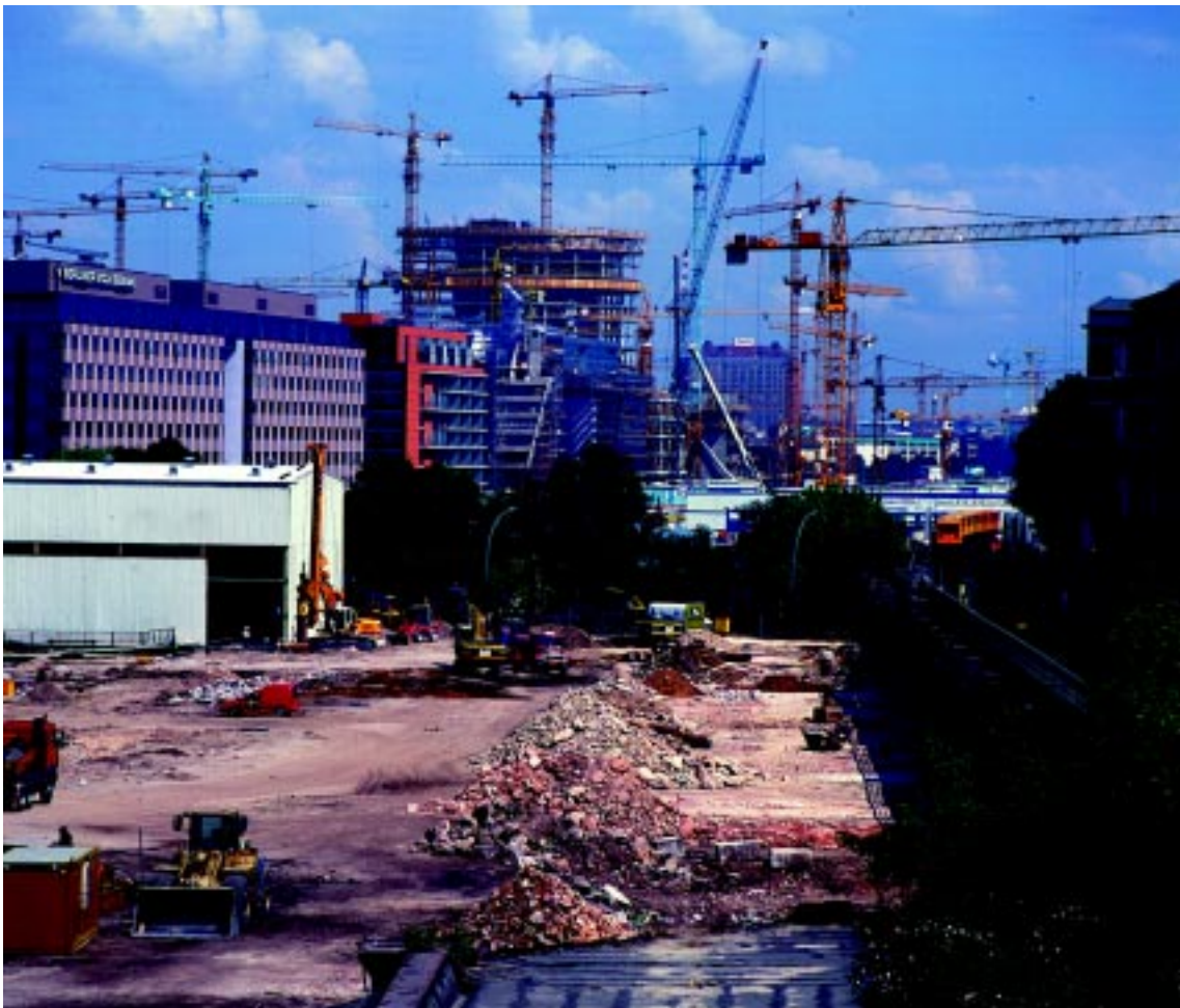
Abb. 8 Baustelle Potsdamer Platz
