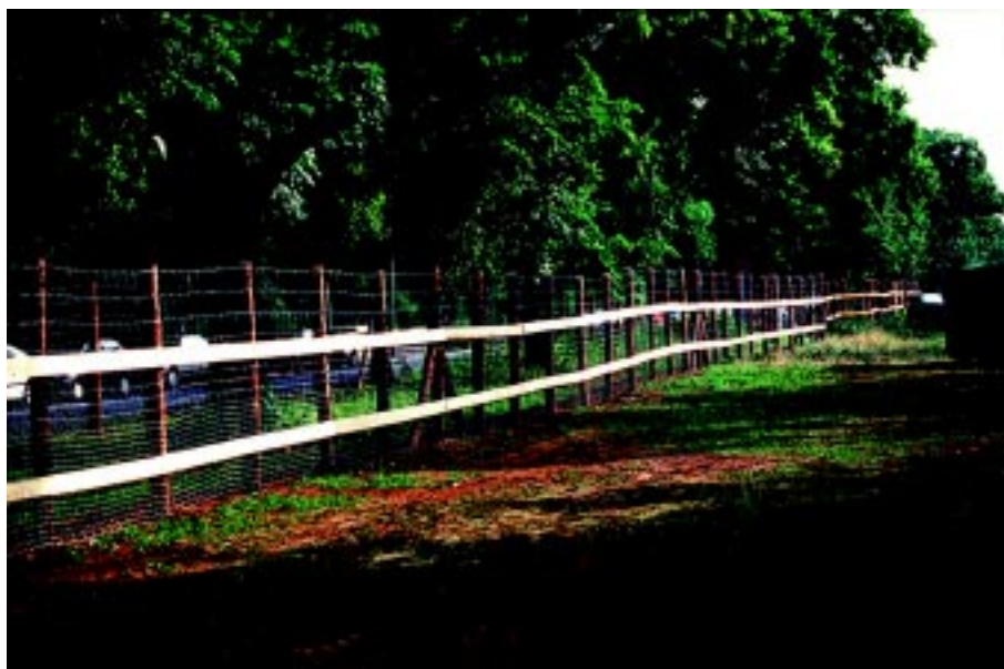
Abb. 12 a Vermeidung von Beeinträchtigungen Schutzzaun für Baumbestände bei Bauarbeiten
