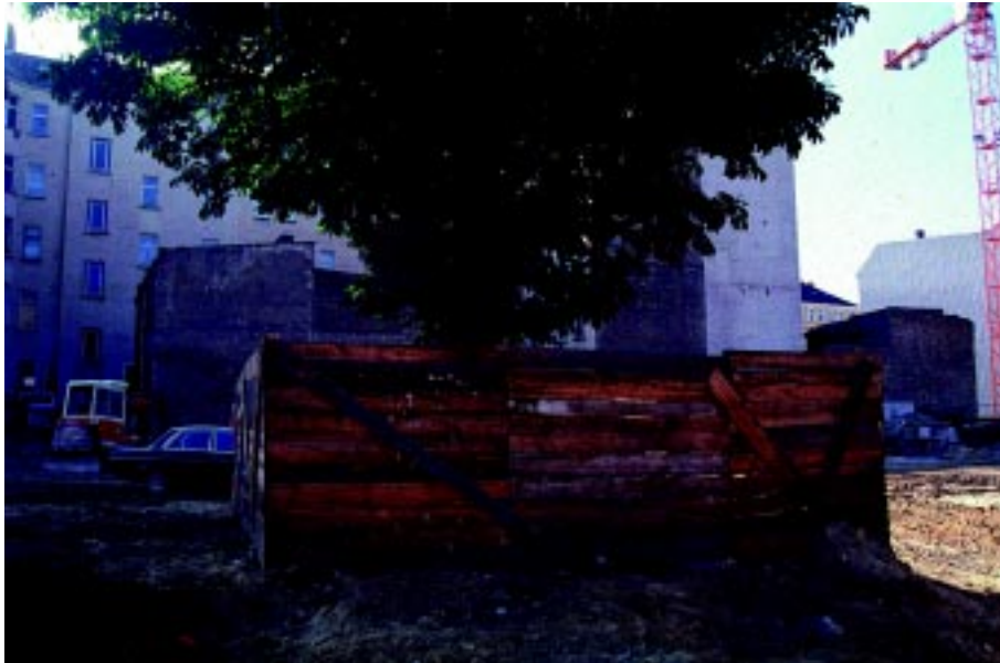
Abb. 12 b Baumschutzzaun Einzelbaum Schutzmaßnahmen bei Bauarbeiten
