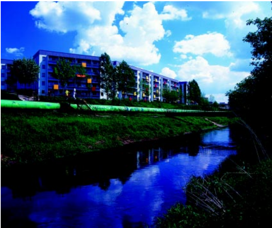
Abb. 9 Fernwärmeleitung im Wuhletal
