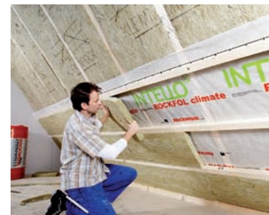
Modernisierungen steigern die Energieeffizienz.
