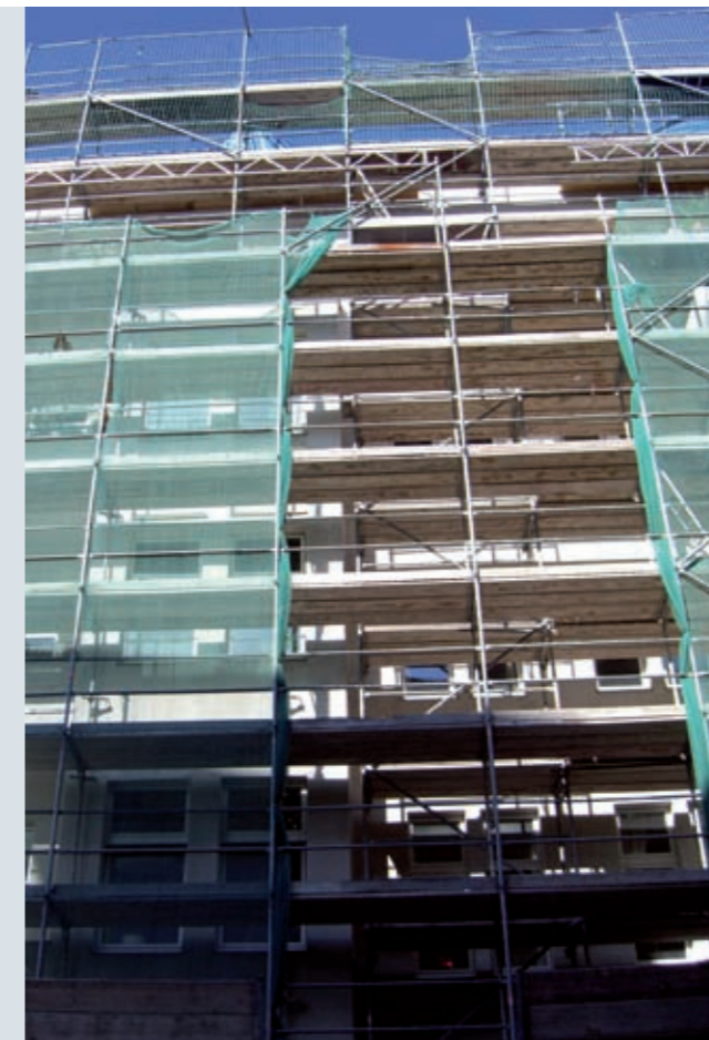
Mit einem Energieausweis kann bei Bewohnern Verständnis für Sanierungsmaßnahmen geschaffen werden.
