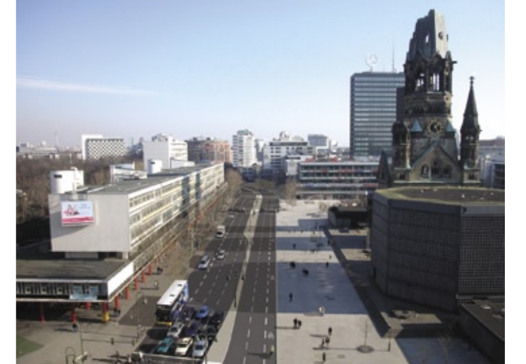
Ausbauzustand ohne Tunnel am Breitscheidplatz
